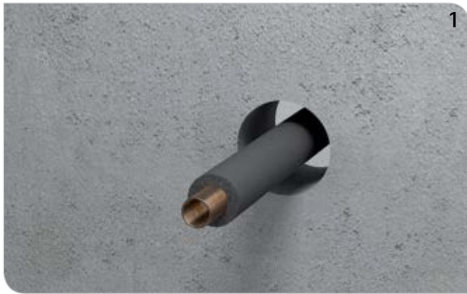
Rohrleitung mit Dämmung installieren.
