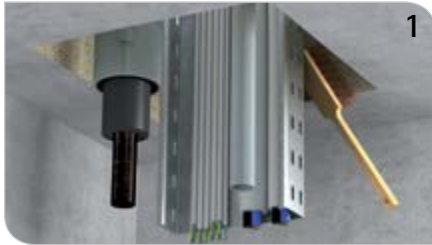
1 Deckenschott säubern und verlorene Schalung mit Klebeband erstellen.
