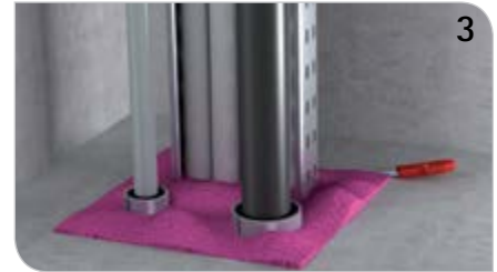
3 Falls gewünscht, überschüssigen Schaum abschneiden.
