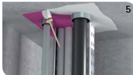
5 Tangit FP 800 Brandschutz-Anstrich unterhalb des Deckenschotts auf den Schaum und 3 cm des angrenzenden Bereichs, bzw. und 15 cm auf die Kabel(-trasse) auftragen.
