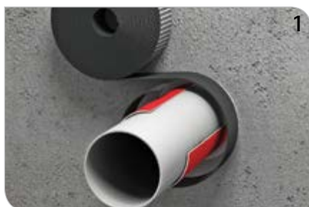
1 Brandschutzband um Rohrleitungen (bzw. Dämmung) legen (Lagenanzahl beachten!) und Überlappung (ca. 20 mm) verkleben.
