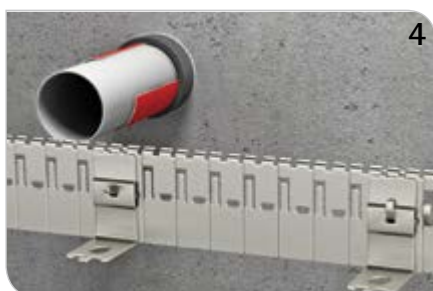
4 Haken einhängen und die umgebogene Nase des Metallbandes über den Haken zurückbiegen.
