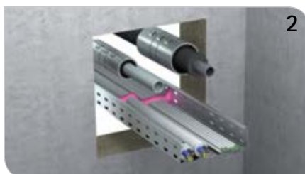
2 BIS Pacifyre® MK II Brandschutzmanschette (Seite 28 - 31) anbringen.
