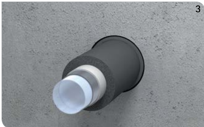
Bandage in Bauteilöffnung schieben (bündig mit Bauteiloberfläche).
