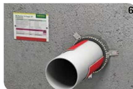
6 Andübeln der Haken mit dem mitgelieferten Befestigungsset. Das Kennzeichnungsschild ausfüllen und neben der Abschüttung anbringen.
