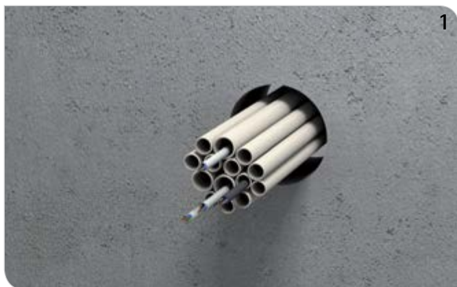
Kabelleerrohre durch das Bauteil führen und außerhalb des Bauteils mit Kabelbinder o. ä. bündeln.
