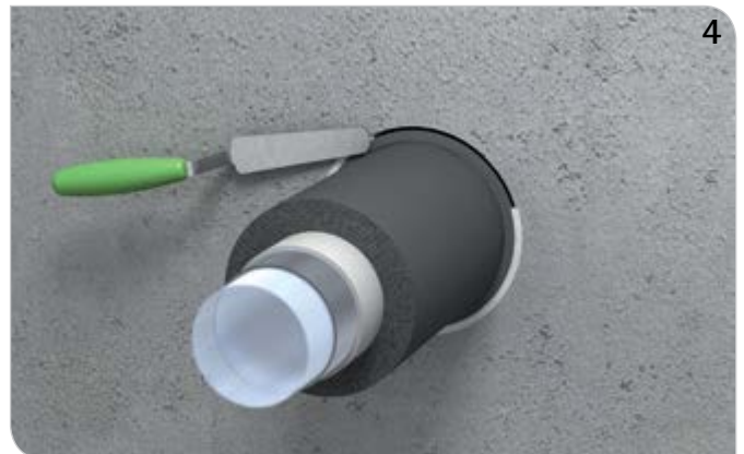
Rest- bzw. Ringspalt rauchgasdicht (mit z. B. BIS Pacifyre® FPM Brandschutzmörtel) verschließen.
