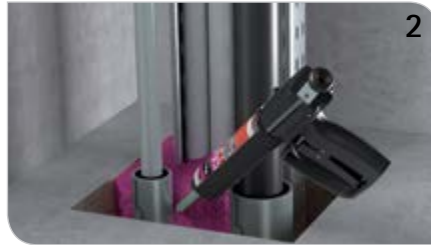
2 Tangit FP 550 Brandschutz-Schaum einbringen.
