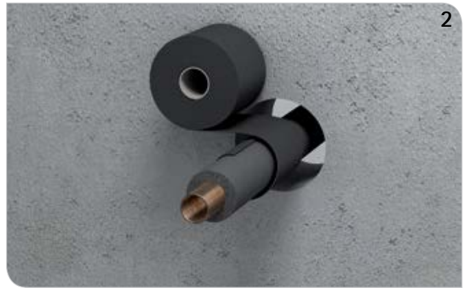
Rohrummantelung um die Dämmung legen (Lagenzahl beachten!) und Überlappung (ca. 20 mm) verkleben.
