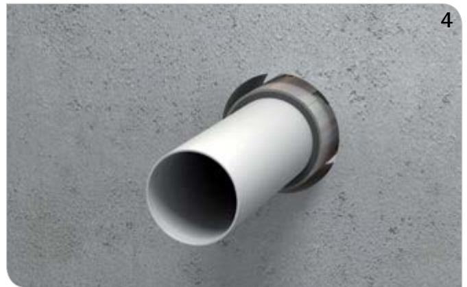
Manschette in die Bauteilöffnung schieben (Überstände beachten).
