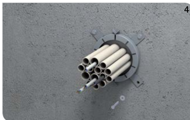
Die ausgewählte Manschette montieren.
