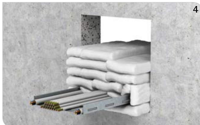
Restöffnungen stoßversetzt mit BIS Pacifyre® IWC Brandschutzkissen verschließen.
