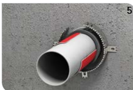
5 Zum Verschluss des Metallbandes 2 Nasen am Ende des Bandes aufbiegen. Beide Enden übereinanderlegen und Nasen zurückbiegen, um Band zu verschließen.
