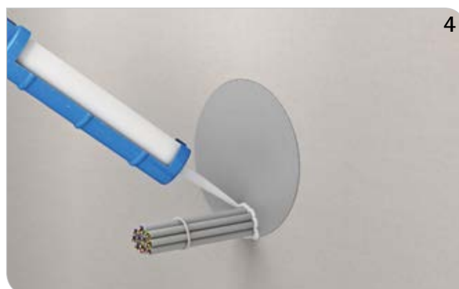
Restspalte mit BIS Pacifyre® IWP Brandschutzkitt verschließen.
