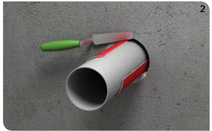
Restpalt rauchgasdicht (mit z. B. BIS Pacifyre® FPM Brandschutzmörtel) verschließen.
