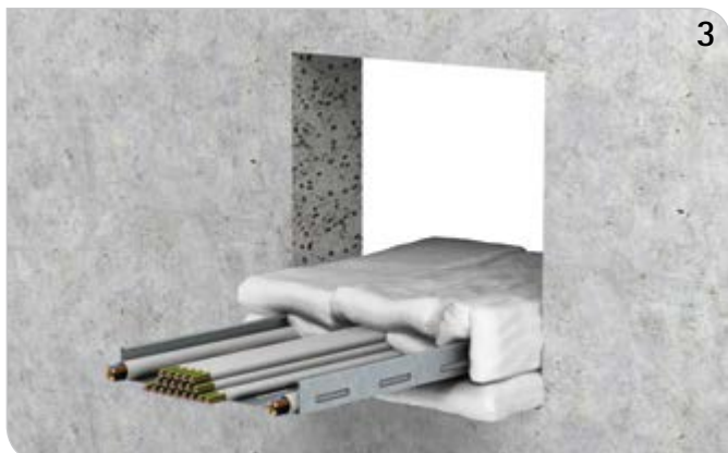
Die Lagen der BIS Pacifyre® IWC Brandschutzkissen so dicht wie möglich um die Kabel verlegen.
