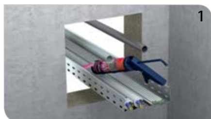
1 Tangit FP 450 Brandschutz-Paste in Bauteilstärke um und zwischen die Kabel flächig auftragen.
