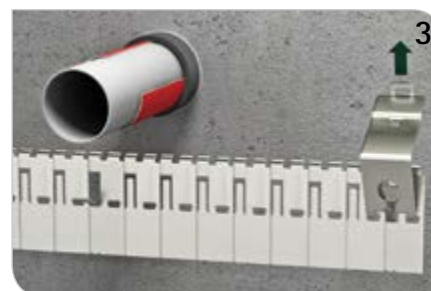
3 Befestigungspunkt für Haken festlegen, durch Aufbiegen der Nasen des Metallbandes um 90°
