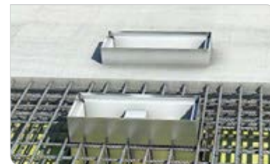
Abschottung von Rohr- und Kabeldurchführungen durch Decken..
