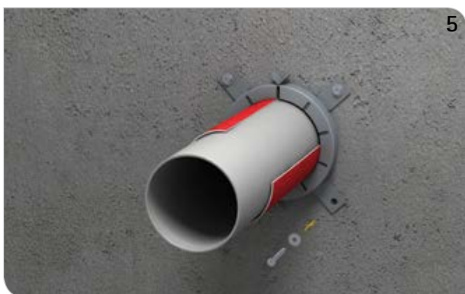
Andübeln der Haltetasche mit dem mitgelieferten Befestigungsset.
