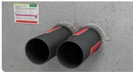
Nullabstand gedämmte Rohre
