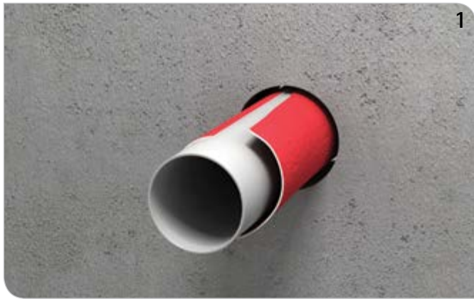
Rohrleitung (ggf. mit Schallschutzschlauch) installieren.
