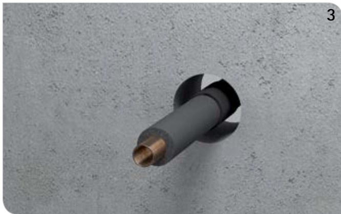
Rohrummantelung in die Bauteilöffnung schieben (Überstände beachten).
