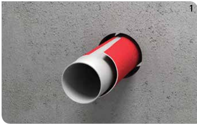
Rohrleitung (ggf. mit PE-Schallschutzschlauch) durchführen.
