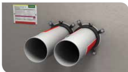
Nullabstand in leichten Trennwänden und Massivbauteilen
