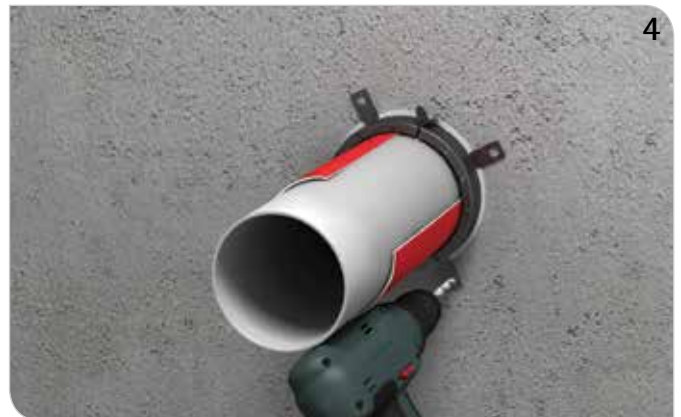
Ggf. anzeichnen und erstellen der Befestigungspunkte (optional dürfen die Laschen auch 90° umgebogen und eingemörtelt werden).
